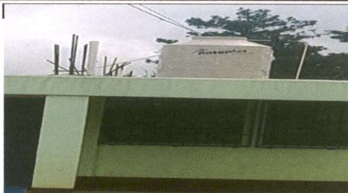
Foto 8: Sustitución de deposito de agua de 1,100 litros
