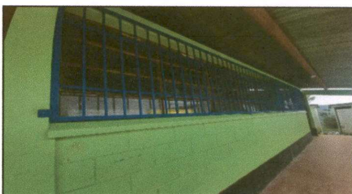
Foto 4: Sustitución de balcones de metal
