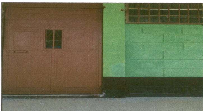
Foto 3: Sustitución de puertas de metal
