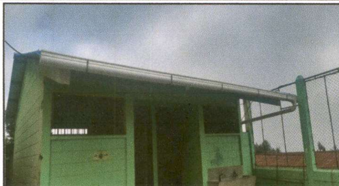
Foto7: Sustitucion de lámina por lámina troquelada calibre 26 Escuela
