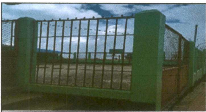
Foto 5: Sustitución de barandas de metal en muro
